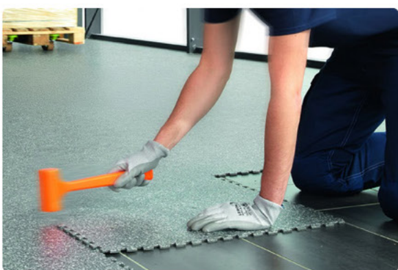
KEMMLIT-Bauelemente GmbH B1.5 GTI Bodenverlegung Tglich 12.30 Uhr
